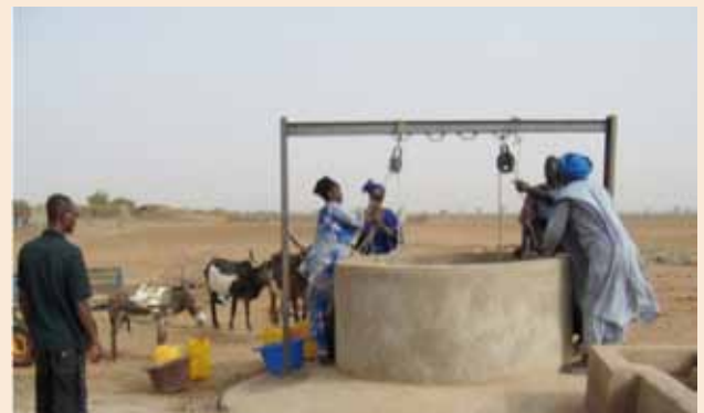
Puits à grand diamètre
