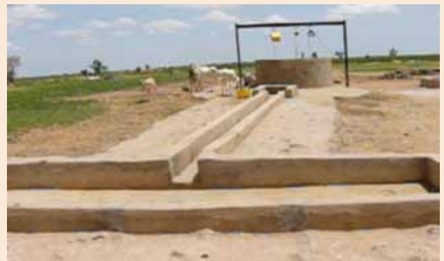
Puits équipé d'un abreuvoir
