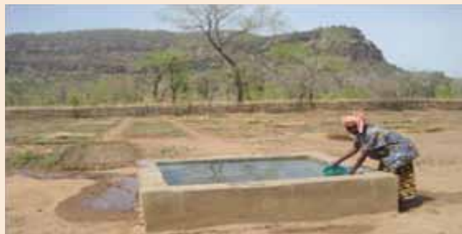
Système de pompage installé par le Mali-Folkecenter
