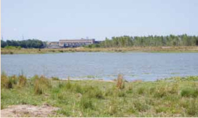
L'état de dégradation des berges avant l'intervention de l'ADCOPS
