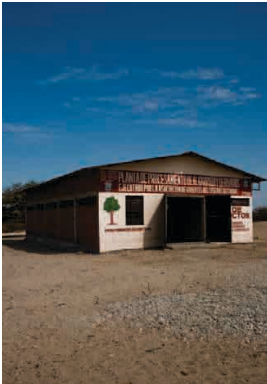
» La planta de Chutuque está a pocos metros de la carretera Panamericana Norte.
