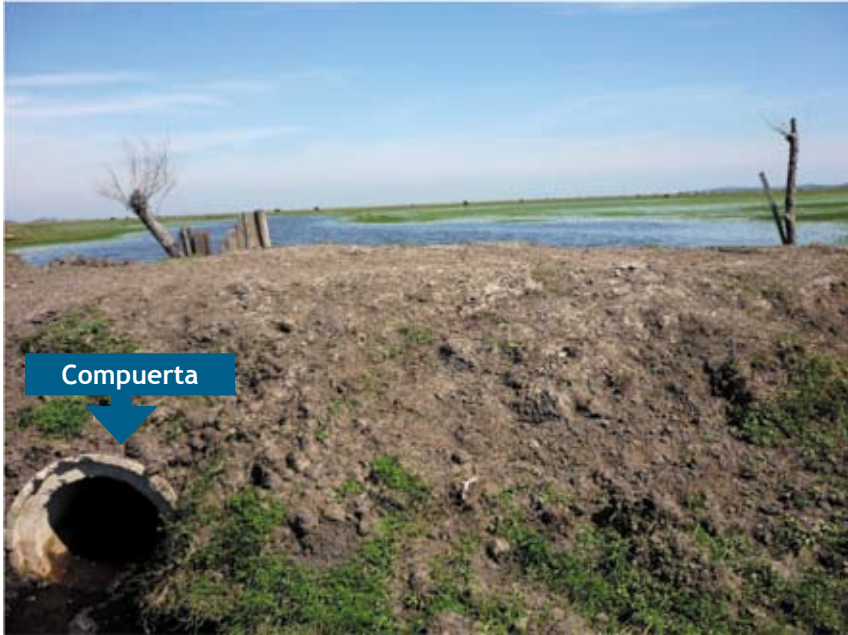
Imagen del dique con la compuerta para desaguar los excesos de agua, principalmente en el invierno. Foto: D. Rodríguez
