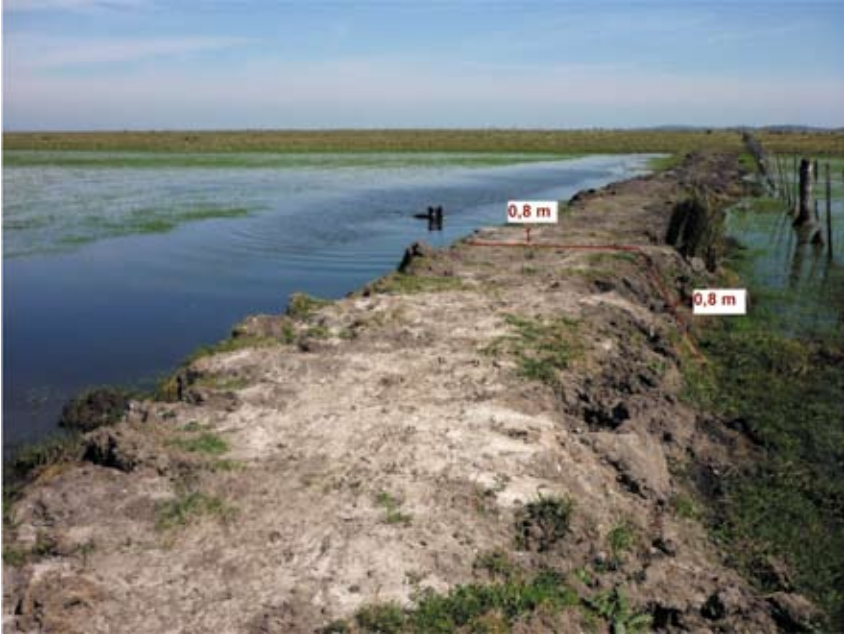
Imagen del dique realizado con tierra para retener el agua de escurrimiento superficial y generar la varge. Foto: D. Rodríguez
