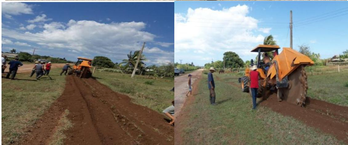
**PERFORACIÓN DE UNOS 4 KILOMETROS DE ZANJA PARA LA INSTALACIÓN DE LA CONDUCTORA DE AGUA, QUE PERMITIRÁ EL RIEGO AGRÍCOLA Y EL ABASTO A LA COMUNIDAD DE LA GLORIA.**
