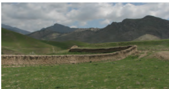
Ограждение участка глиняным дувалом.
