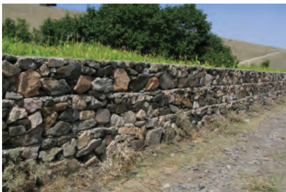
Ограждение участка каменным забором.
