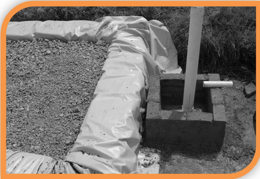
*NOTA: Este pequeño tubo de desagüe de la cámara de salida puede ser conectado a un tanque de almacenamiento para disponer de esta agua para riego. También puede conectarse a una zanja de infiltración a nivel, en la tierra donde el agua se infiltre en el suelo, pudiéndose utilizar para árboles u otras plantas*
