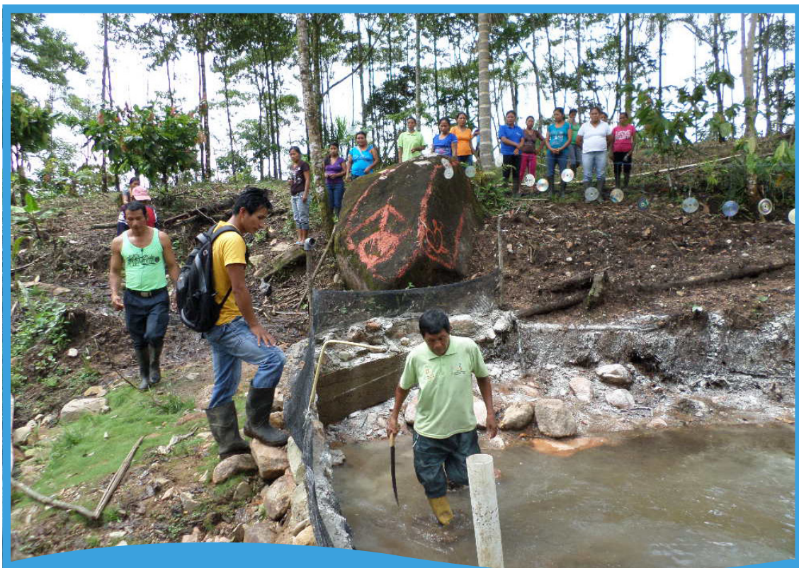
Construcción de estanque en suelo con presencia de piedra
