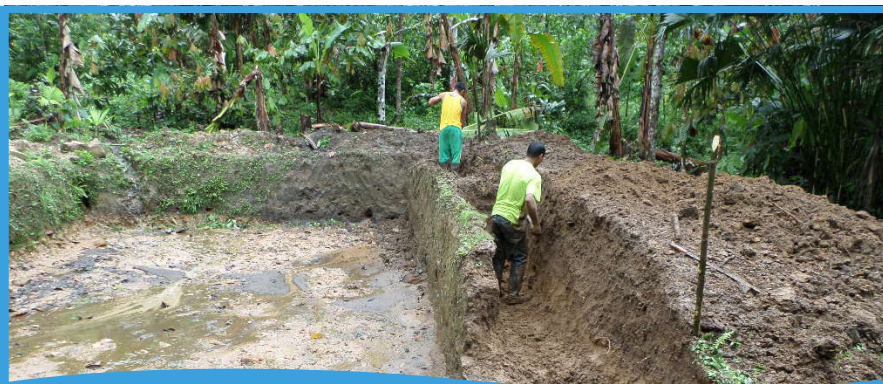
Ampliación de estanques construidos antes del proyecto
